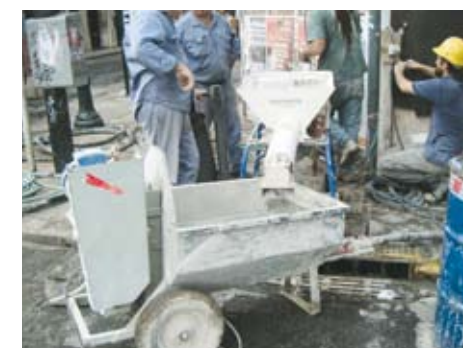
Fotografías Nro. 5 y 6. Colocación de los morteros haciendo uso de una manguera flexible de 50mm. de diámetro.
