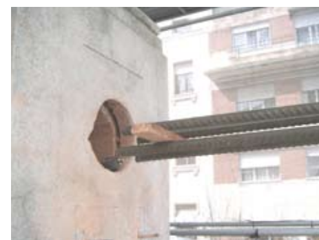
Fotografía Nro. 4. Barras ingresando al conducto.
