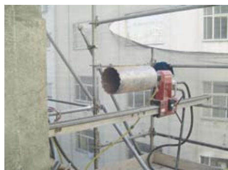
Máquina utilizada para la ejecución de perforaciones
